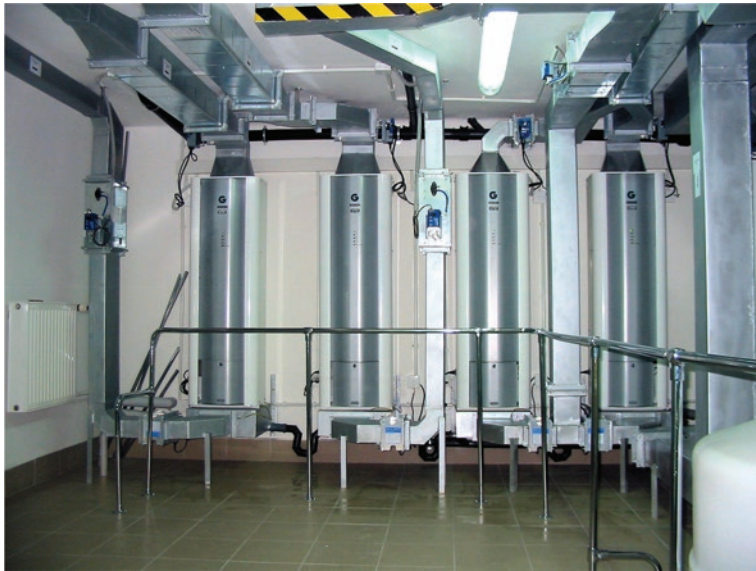
Rys. 1. Instalacja do oczyszczania powietrza w boksach Meltzera w technologii Genano
